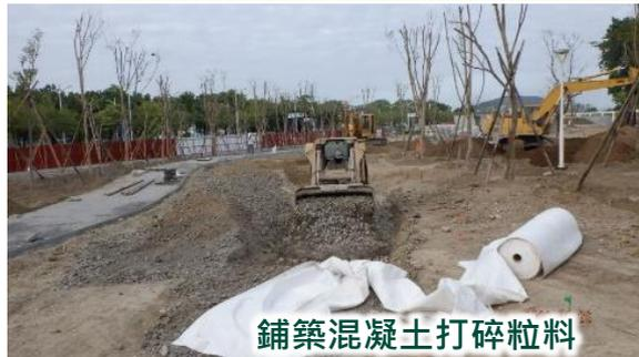
鋪築混凝土打碎粒料
