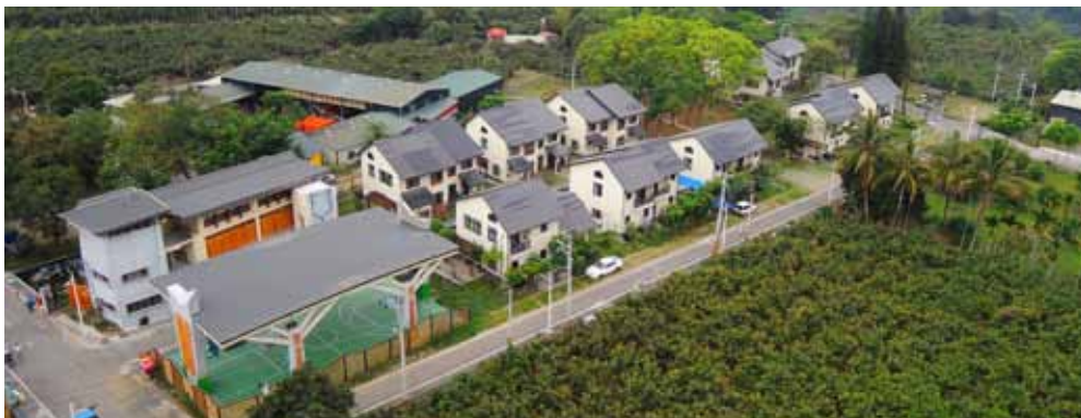
► 樂樂段永久屋基地全貌
