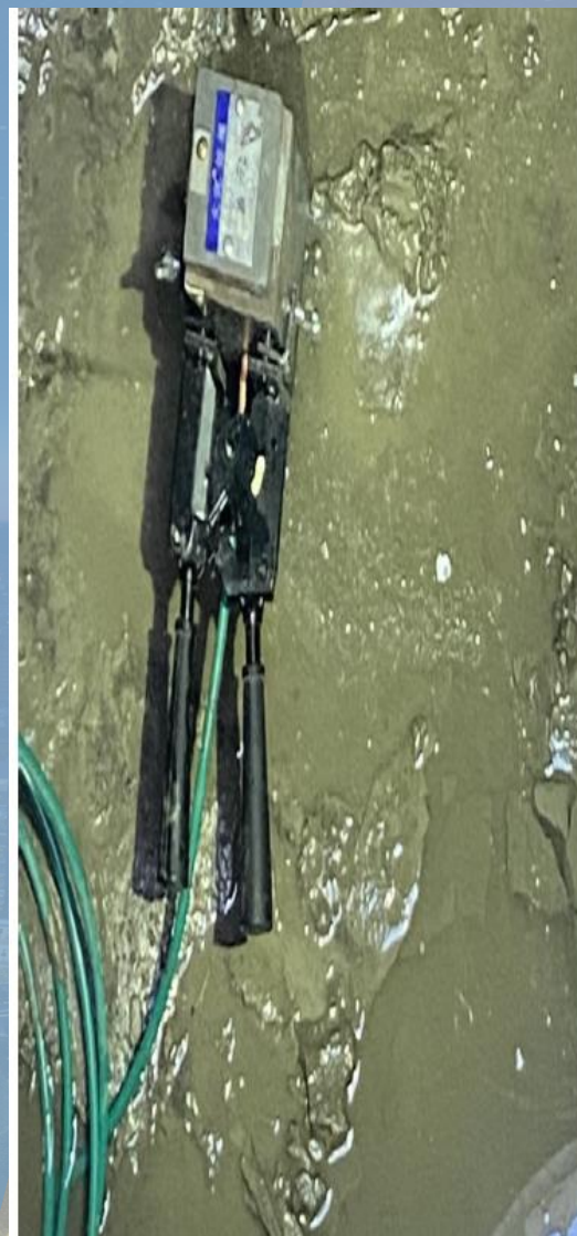
說明一 熔接模具及焊藥。
