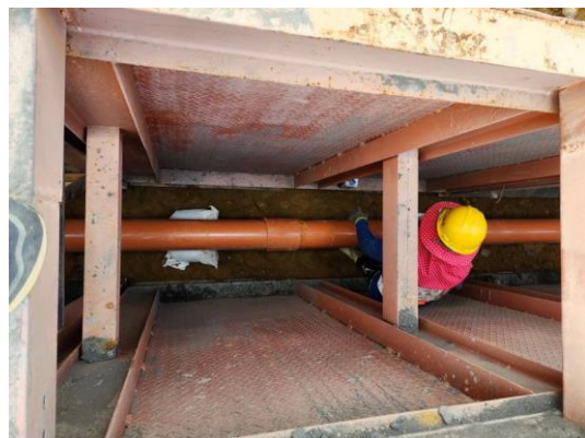
▲圖 2. 增加擋土支撐，預防倒塌、崩塌危險。
