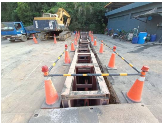
▲圖 2. 增加擋土支撐，預防倒塌、崩塌危險。
