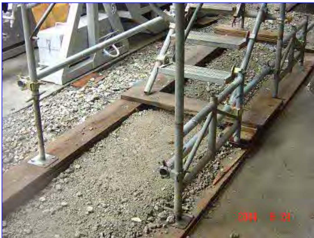
照片 9：施工架底部之立架設可調型基腳座鉸，基礎地面應平整、夯實緊密、襯以適當材質之墊材，以避免產生不均勻沉陷。
