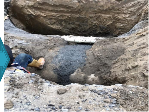
速凝砂漿填補
