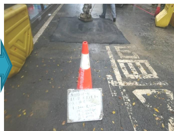
鋪設瀝青面層
