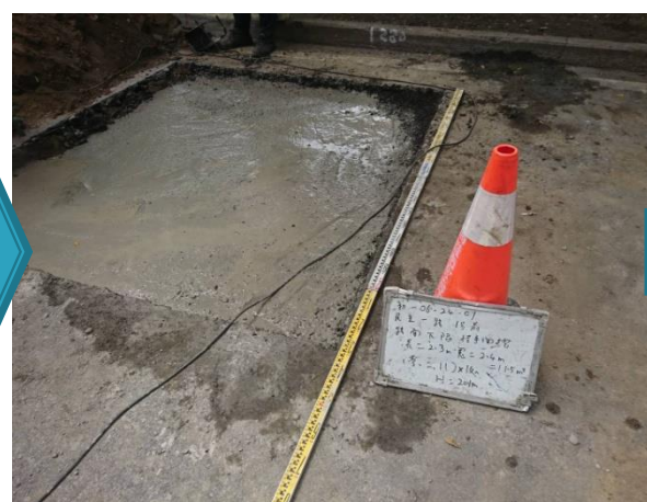
加速通車時間，採140kgf/cm 2 預拌混凝土回填
