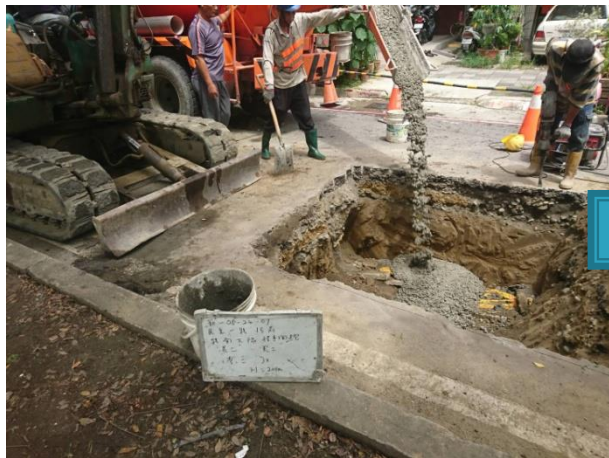
加速通車時間，採140kgf/cm 2 預拌混凝土回填
