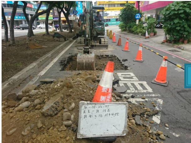
坑洞處切割及開挖
