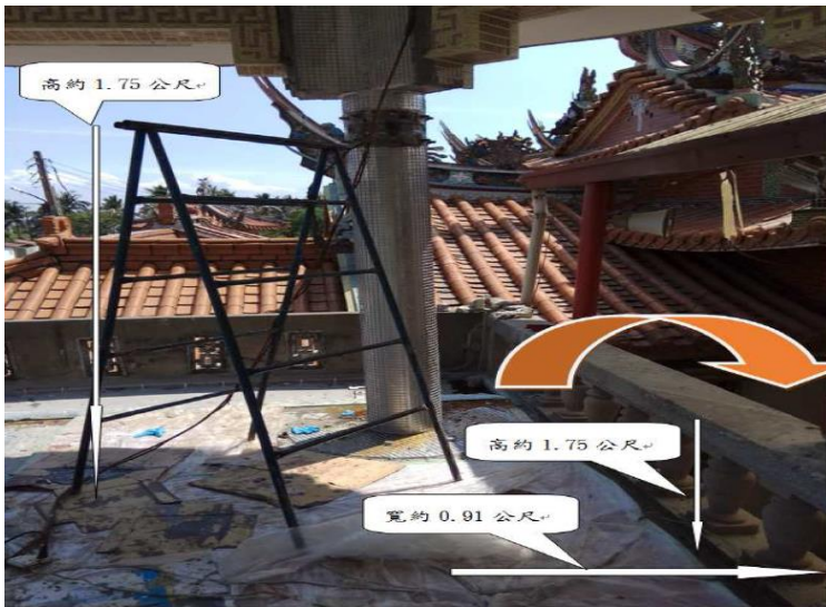
圖 1 罹災者施工現場墜落示意圖。
