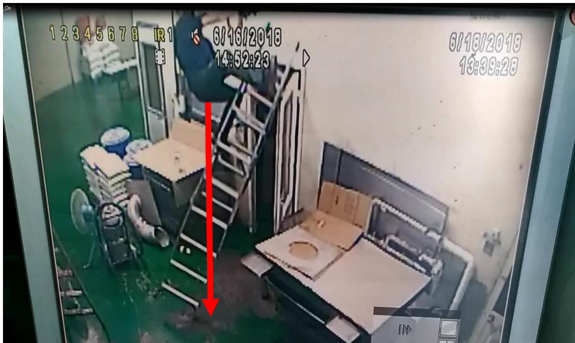
圖 2 罹災者所踩肇災合梯產生晃動, 從肇災合梯上向後傾倒墜落。
