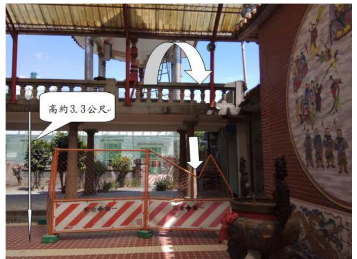
圖 2 罹災者墜落撞擊圍籬頂桿之情形。
