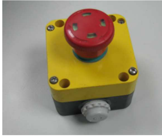
照片2 進入車廂頂或機坑工作將自動控制切換為手動狀態
