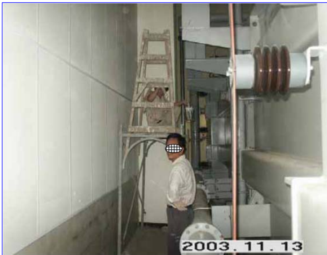
照片 12：施工架上違規設置合梯從事油漆作業。
